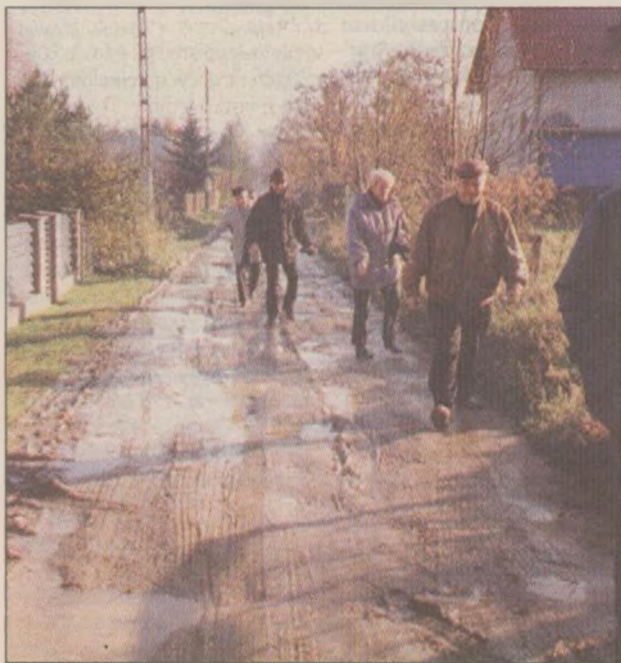
Przebrnięcie suchą nogą przez ul. Niedzielną w Osoli nie jest sprawą prostą. Z różnym skutkiem próbują tego dokonać Stanisław Maksymowicz, sołtys Janina Janeczko (mieszkająca w pobliżu), Lech Kwiatkowski i Michał Posypanko.
