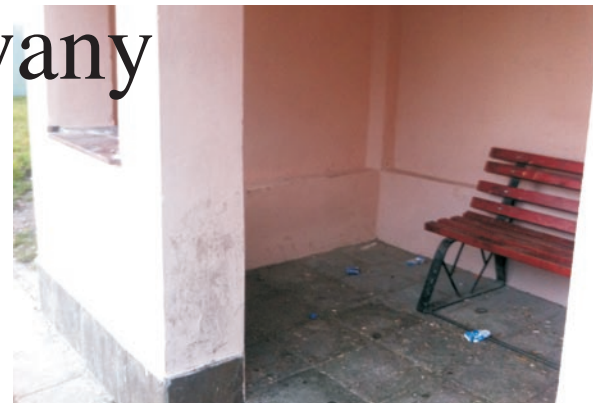
Aż trudno uwierzyć, że po remoncie minęło zaledwie kilka dni
