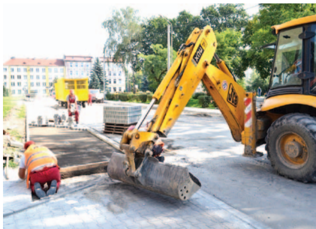
Trwają ostatnie roboty przy przebudowie drogi powiatowej nr 1578D, czyli ulicy Żołnierza Polskiego w Oławie
