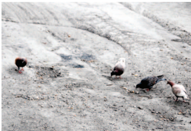
Dziury zasypane, problem rozwiązany?
