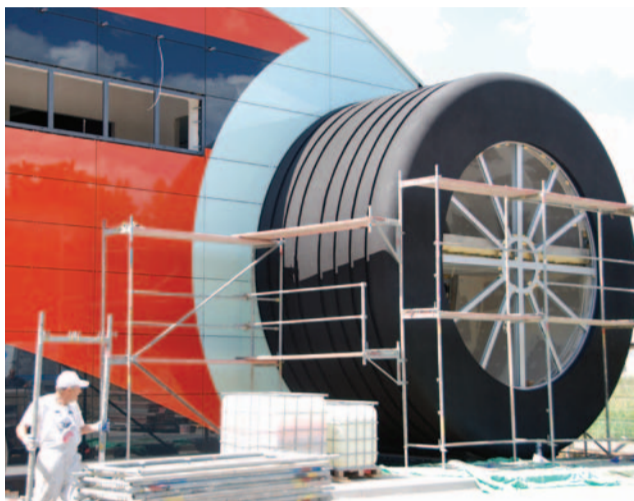
Opony jak prawdziwe. Tu, gdzie dojdą felgi, będą okna tego niezwykle biurowca
