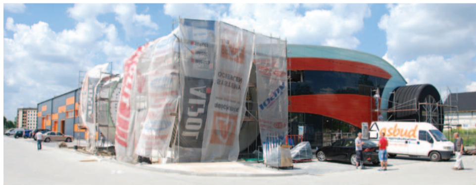
Całość budowy jest na ukończeniu
