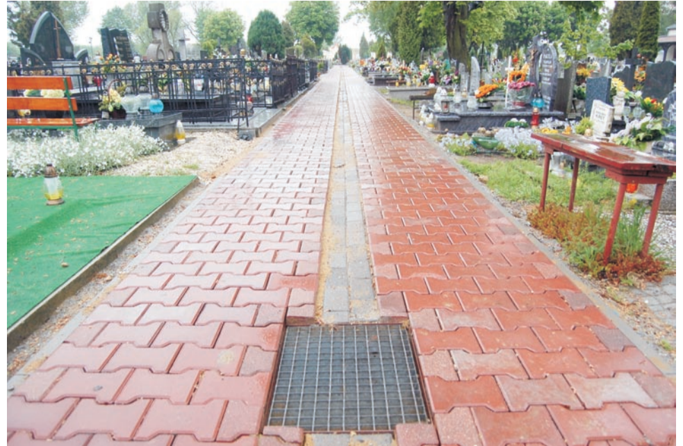
Nie ma kanalizacji deszczowej, a takie studzienki nie wystarczają, by przy intensywnych opadach, szybko odprowadzić deszczówkę
