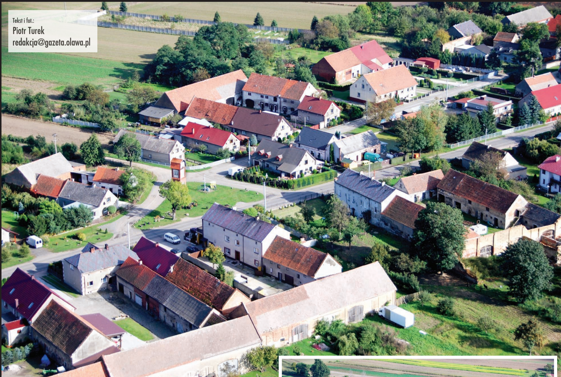
W centrum Chwalibóżyce łatwo dostrzec skrzyżowanie dróg i wieżę transformatorową
