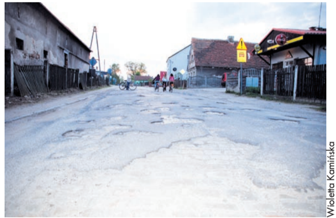
Droga powiatowa przeznaczona do budowy
