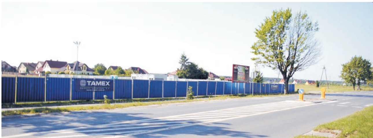
Na początku tego tygodnia wykonawca ogrodził plac przy ulicy Oławskiej, gdzie ma stanąć hala
