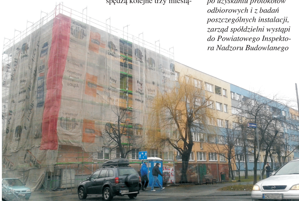
Lokatorzy budynku, w którym w grudniu ubiegłego roku wybuchł gaz, wprowadzą się do wyremontowanych mieszkań prawdopodobnie w czerwcu tego roku
