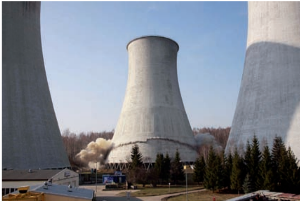
Z myślą o nowej inwestycji elektrownia wyburzyła już część starych chłodzi.
