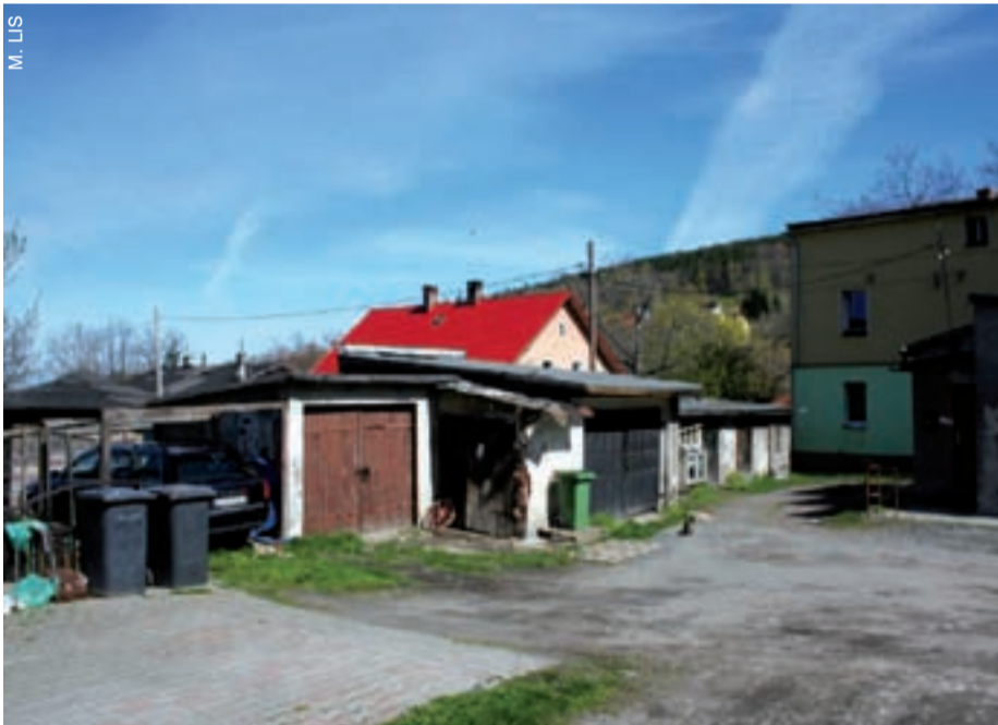
Komórki, miejsca parkingowe, szambo - to wszystko od kilku miesięcy znajduje się na prywatnym gruncie. Mieszkańcy budynków przy ul. Grunwaldzkiej w Świeradowie boją się myśleć, co będzie, gdy właściciel zażąda ich rozbiórki.
