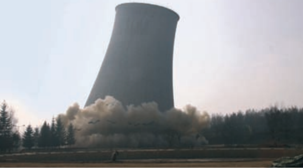
Kilka sekund starczyło, by betonowy kolos runął na ziemię.
