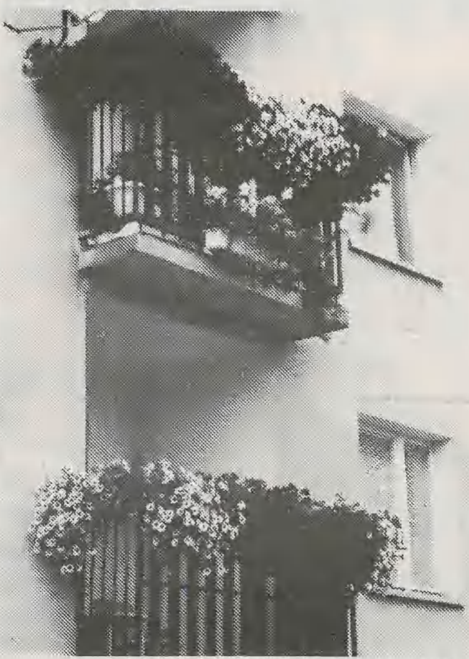
balkony z ul. Izerskiej w Lubaniu
