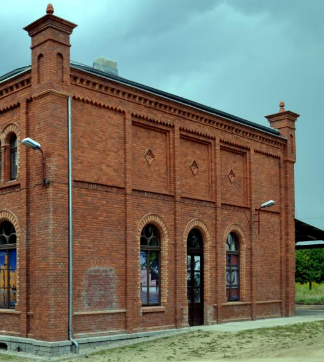
Dworzec kolejowy w Świebodzicach fot. Lichen99 / Wikimedia Commons, 15 sierpnia 2014 roku (CC-BY-SA)
