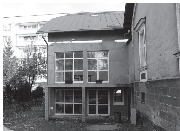
Budynek jest prawie gotowy.
