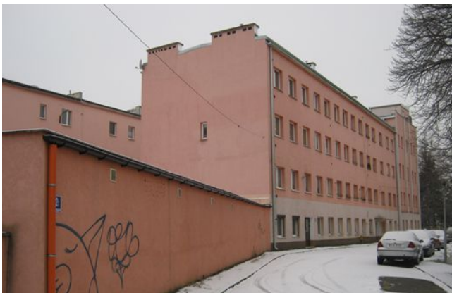
Zabudowania dawnej fabryki zegarów A. Willmann & Co przy ul. Kolejowej 34 w Świebodzicach.
