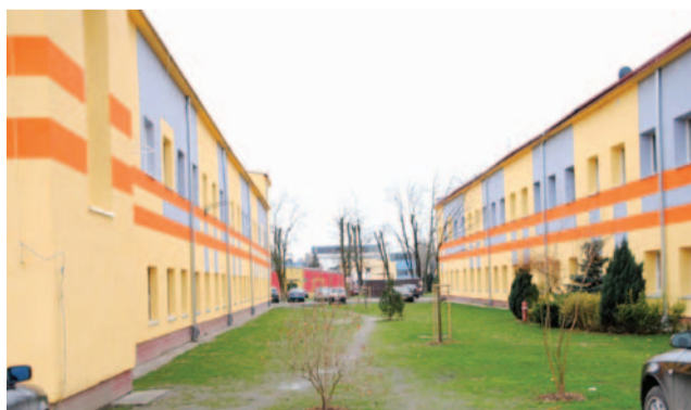
Dzięki LPR przeprowadzono termomodernizację 14 budynków. Trzech gminnych i 11 wspólnotowych
