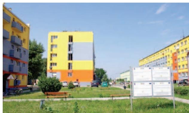
Program rewitalizacji zrealizowano dzięki dotacjom unijnym. Mieszkańców informują o tym między innymi tablice znajdujące się w centrum osiedla
