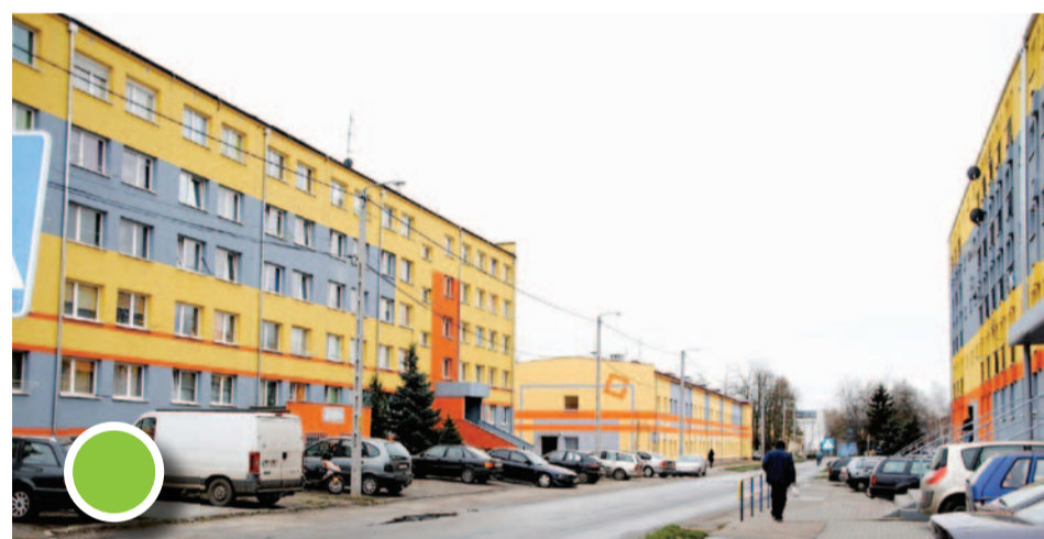
Dziś budynki przy ulicy Techników są kolorowe i docieplone
