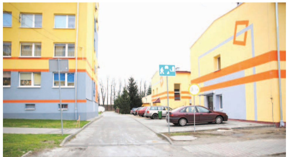
Dzięki realizacji projektu chodniki i parkingi na osiedlu Fabrycznym są z kostki brukowej
