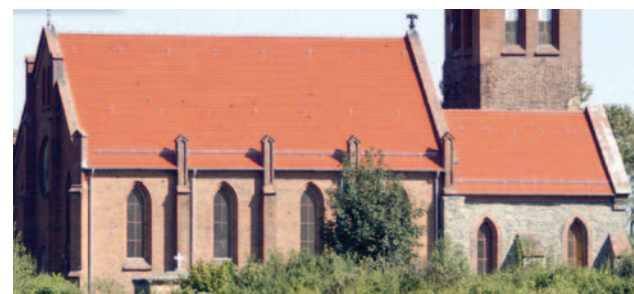
Kościół w Brzemimierzu ma już nowy dach
