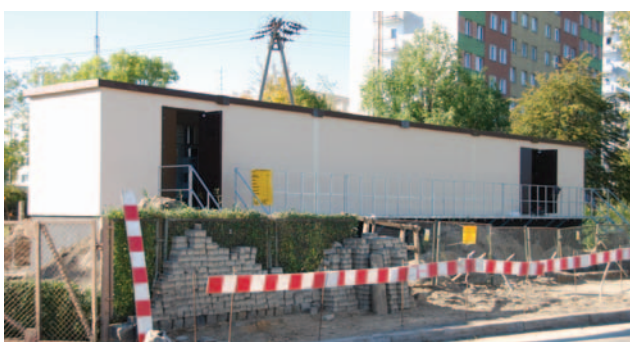
Budowa nowej stacji elektroenergetycznej przy ul. Rybackiej w Oławie ma trwać do końca listopada, ale nie spowoduje to większych przerw w dostawie energii
