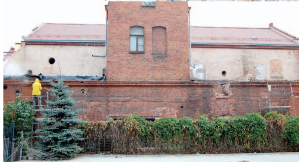
Dach nad główną salą już jest gotowy
