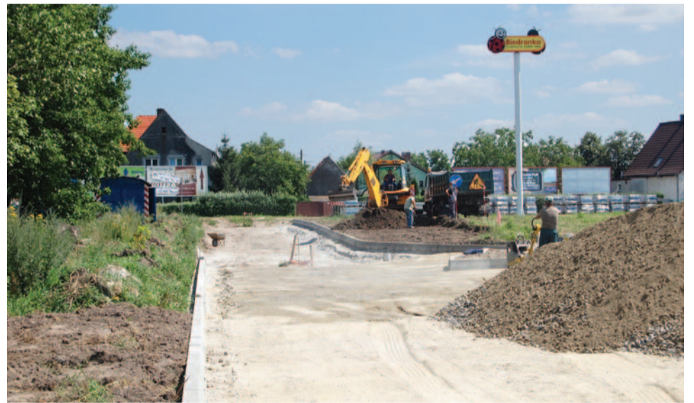
Już trwają prace przy budowie dróg dojazdowych
