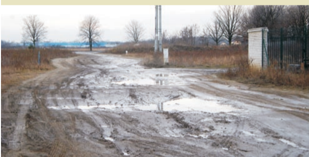
Ulica Wyspiańskiego przed modernizacją...
