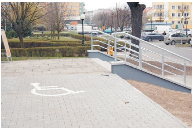
Podjazd na deptak przy pl. Piłsudskiego, od strony ulicy Kopernika...
