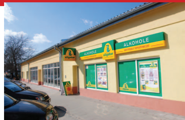
Właściciel dość szybko odbudował spalony obiekt. Działa już tam ponownie sklep „Aligator”, wkrótce ruszy też „Pepco”. Nie wróci tylko na swoje miejsce drogeria „Schlecker”
