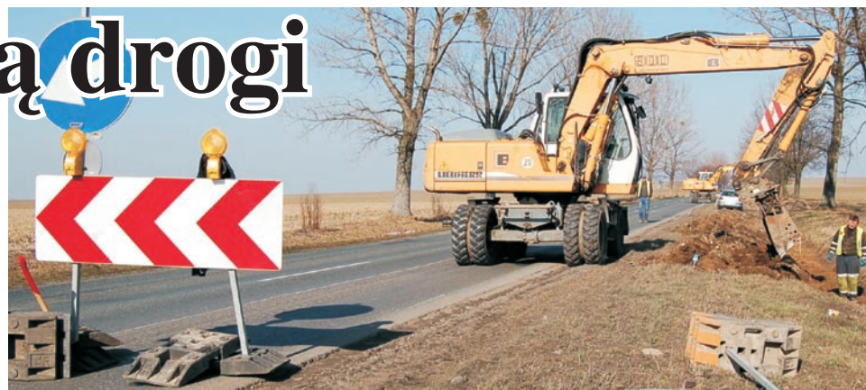
Prace na drodze wojewódzkiej nr 396 między Gajem a Pełczycami
