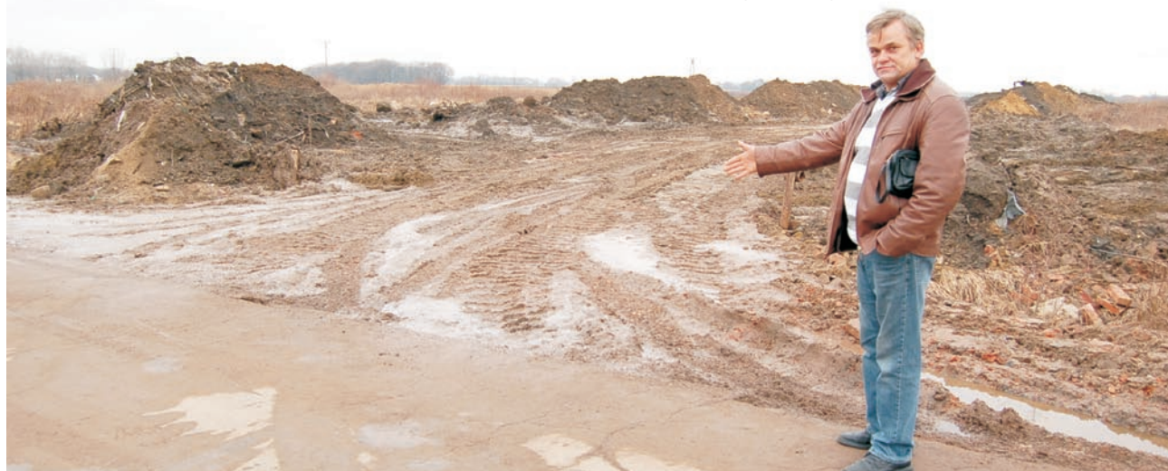
Sołtys Edward Masłowski mówi, że widać znaczną poprawę czystości drogi, bo wykonawca rekultywacji codziennie usuwa błoto z nawierzchni
