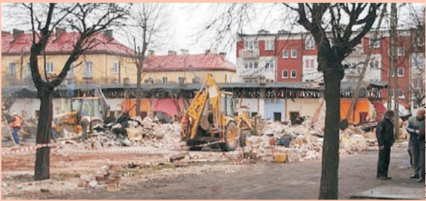
Wyburzenie baraków w Jelczu-Laskowicach
