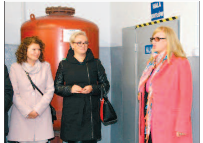
Staraliśmy się, by inwestycję zrealizować jak najszybciej, a przerwa w dostawie wody była zaledwie kilkudniowa - podkreślała Jolanta Suława, szefowa DZT
