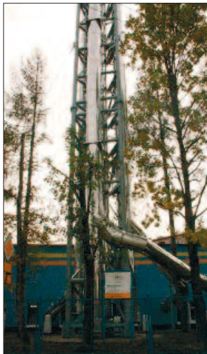
Komin nowej kotłowni wzbudził niemałą sensację na osiedlu - mieszkańcy podobno dopytywali, czy odbywać się tu będzie produkcja biogazu...
