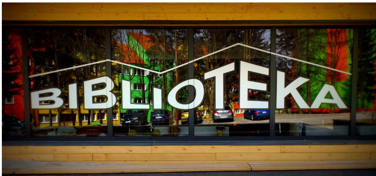
Front budynku MBP w Świeradowie-Zdroju. Fot. Natalia Piotrowska
