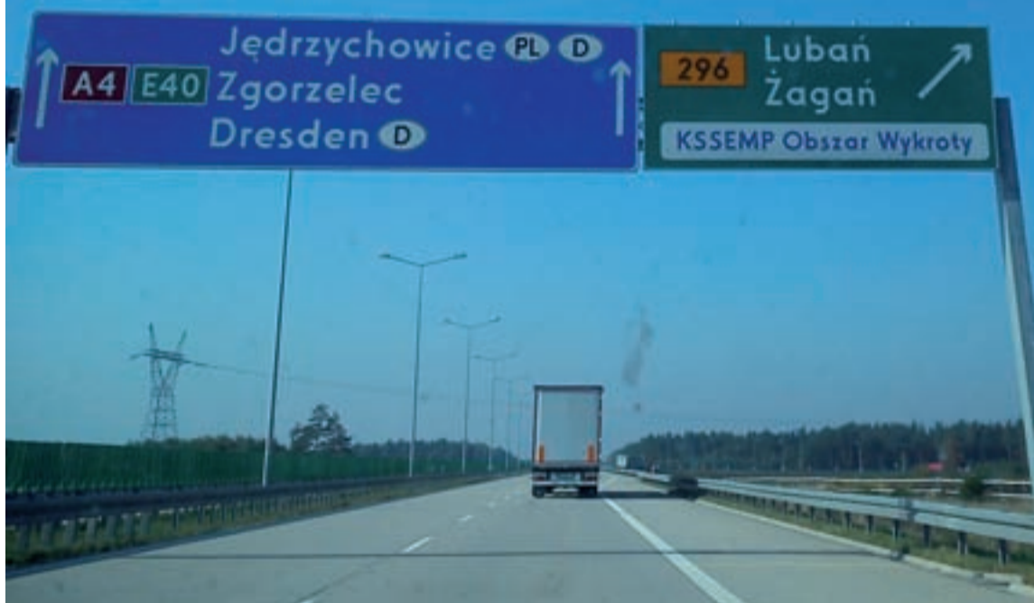
System oznaczeń drogowych przy autostradzie A4.
