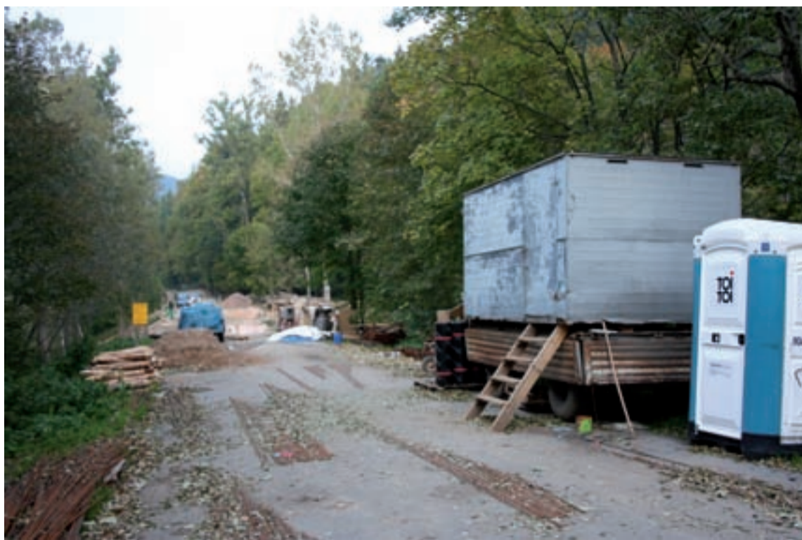
Most w Wojcieszowie zostanie oddany z miesięcznym opóźnieniem. To jednak skutek dodatkowych robót, a nie - jak podejrzewali kierowcy - celowej opieszałości wykonawców.
