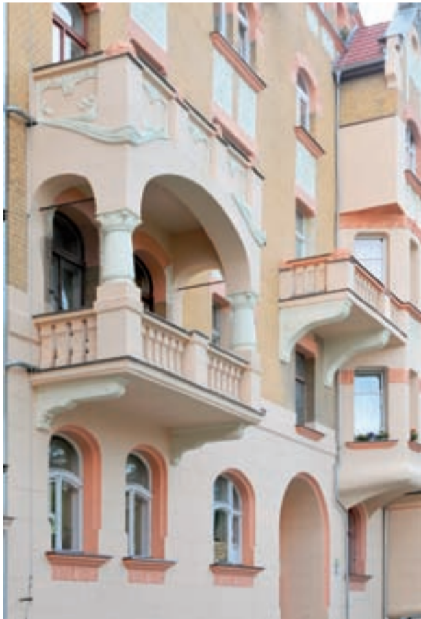
Secesyjna kamienica przy ul. Wojska Polskiego jest najlepszym przykładem staranności wspólnoty przy rewitalizacji domu
