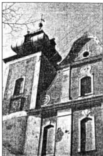
Górna część frontonu kościoła wraz z hełmem wieży kościelnej
