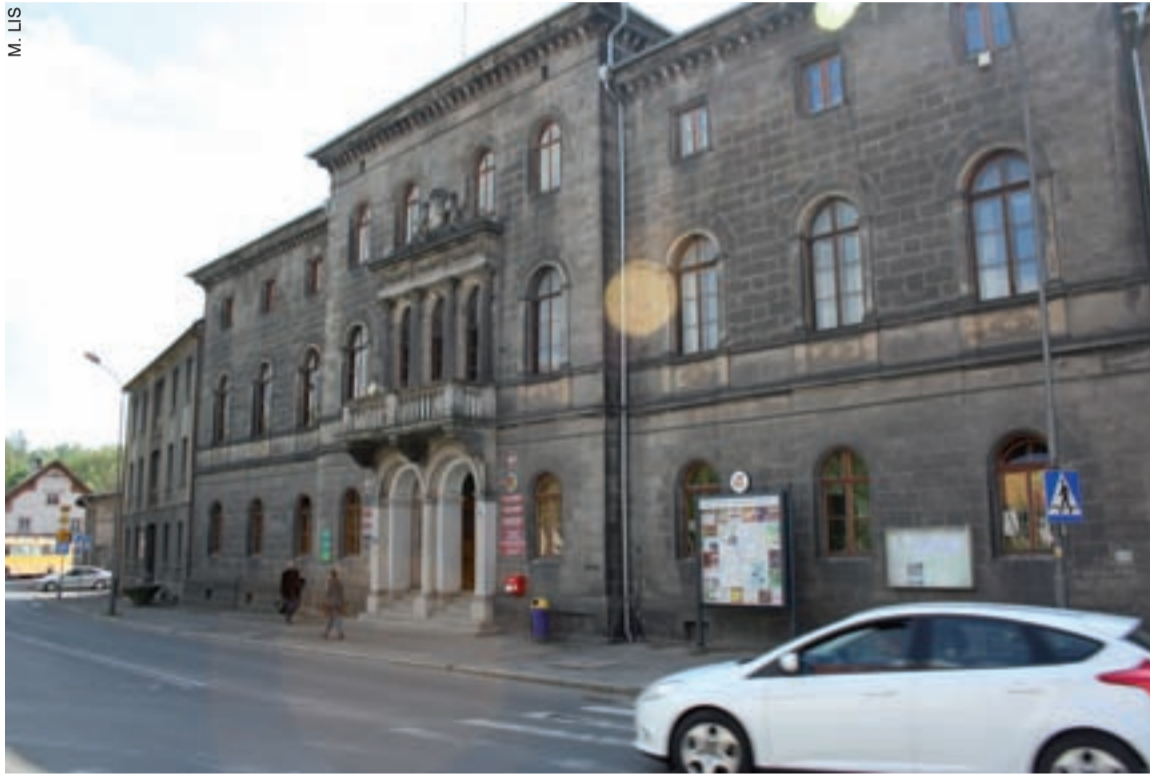
Dany pałac Hohenzollernów w Lwówku to potężny budynek. Ale za mały, by pomieściły się w nim dwa urzędy: gminy i miasta oraz powiatowy.
