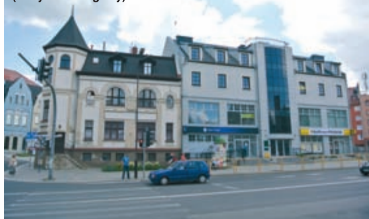
Po latach przerwy, przyznano tytuł Chały architektonicznej (budynek usługowy).
