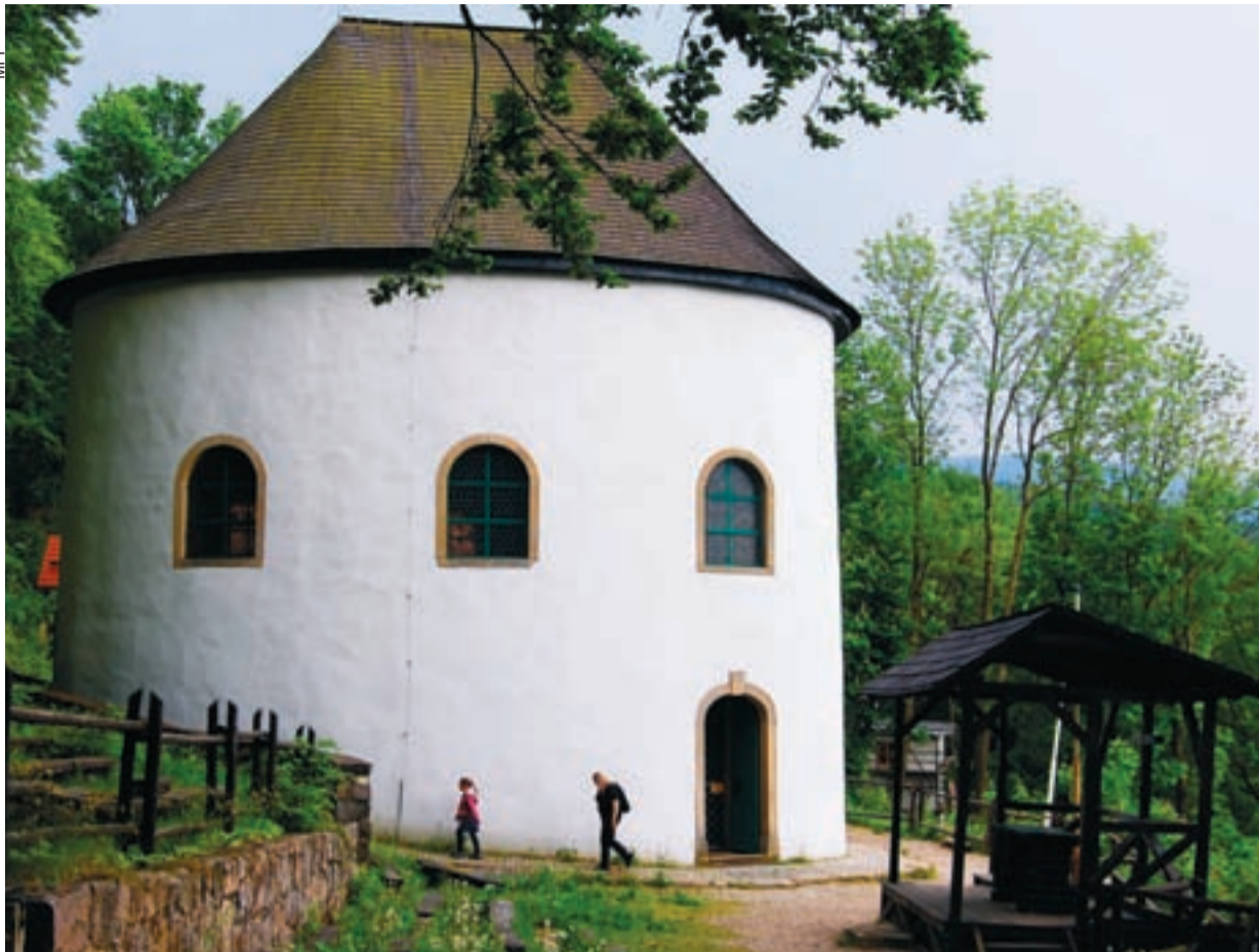
Źródło Dobrej Wody spod ołtarza wyprowadzono na zewnątrz kaplicy.
