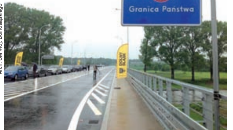
W sobotę uroczyste otwarto nową przeprawę nad Nysą Łużycką.
