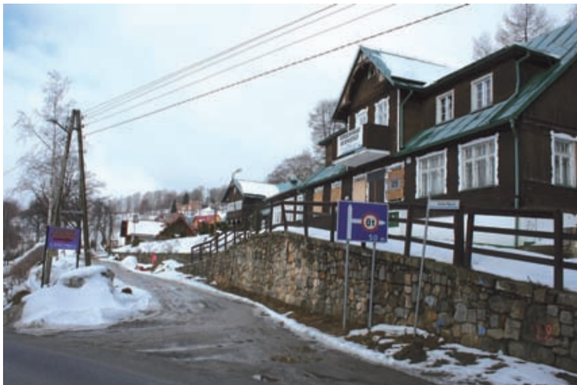
Obiekty „Wzrok I” i „Wzrok II” wraz z trzema hektarami terenu czekają na nabywcę.
