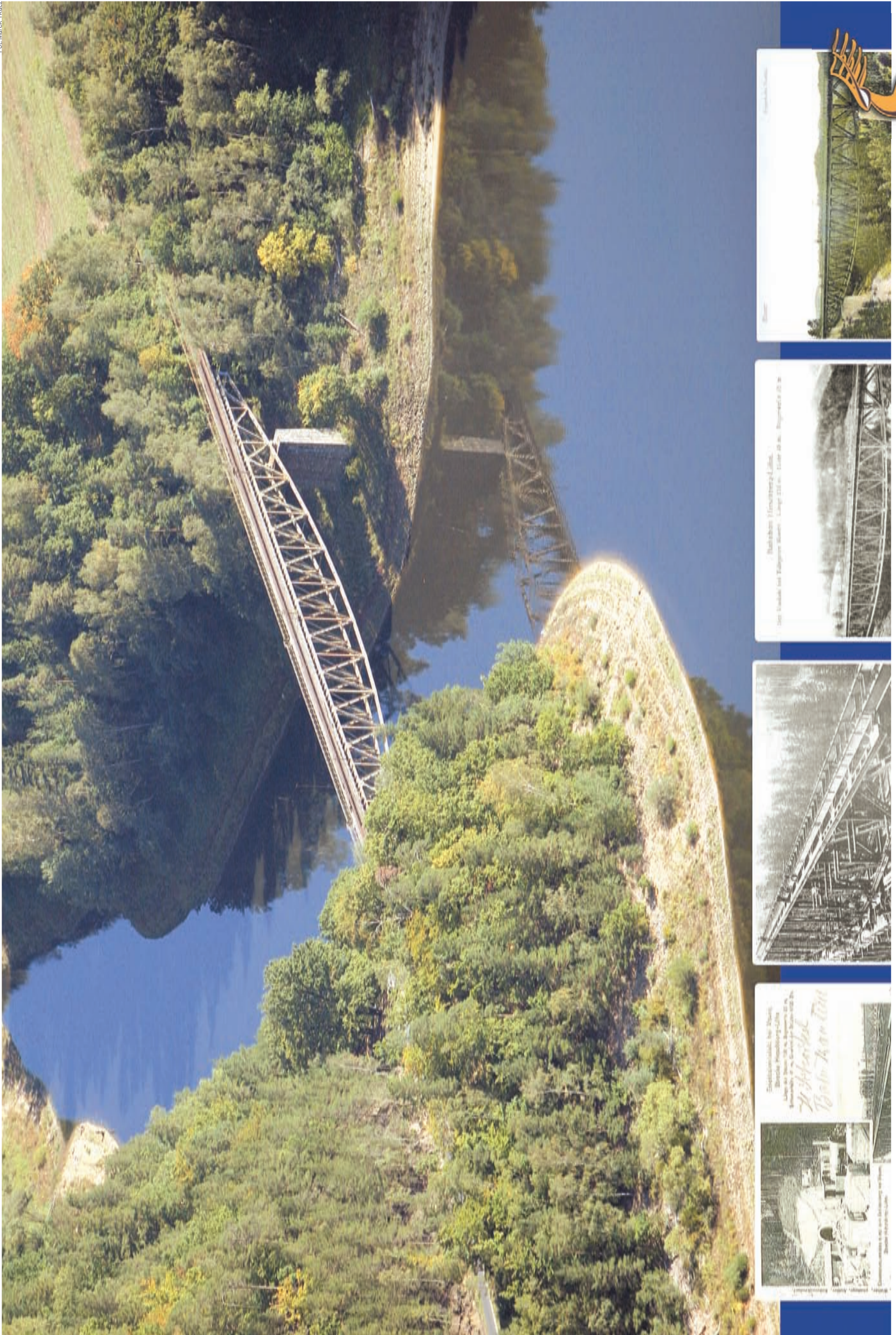
Most na linii kolejowej Jelenia Góra - Wleń - Lwówek Śląski - której stulecie przypada w tym roku - powstał, zanim jeszcze wodą wypełniła się niecka sztucznego zbiornika w Pilchowicach (Mauer). Zbudowano go siłą ludzkich mięśni. Konstrukcja z początku XX wieku do dziś imponuje rozmachem. Most mierzy 130 metrów, przeszło kratownicze ma 85 metrów. Wisi nad lustrem wody na wysokości 40 metrów, co czyni tę przeprawę najwyżej położoną w Polsce. Dodatkowego uroku nadaje mostowi położenie, bo linia do Lwówka jest uważana za jeden z najbardziej malowniczych szlaków w Europie. Szkoda tylko, że ten potencjał nie jest odpowiednio wykorzystany ku zadowoleniu miejscowych i turystów.
