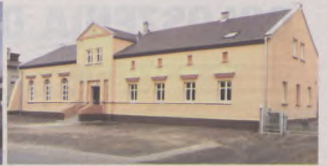
Świetlica po remoncie
