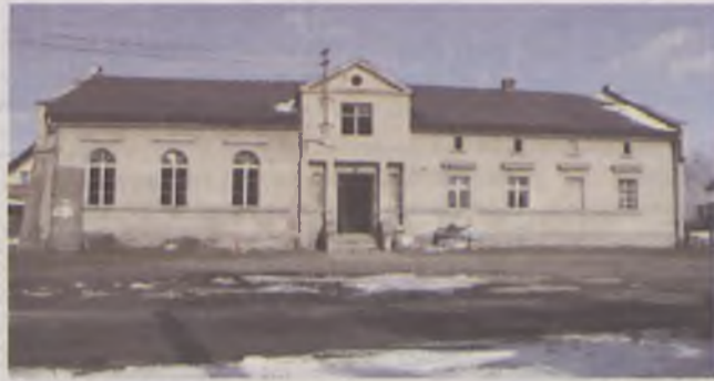
Świetlica przed remontem
