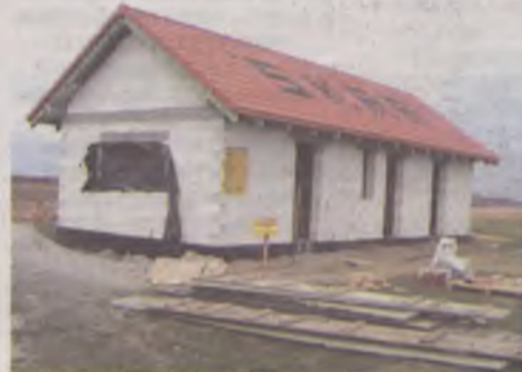
Budowa szatni dla Skry Wojnowice
