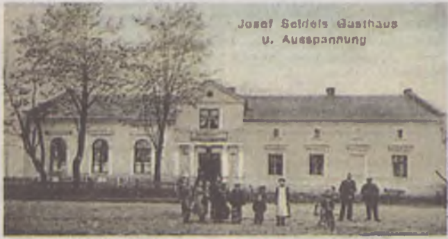
Tak wyglądał budynek dzisiejszej świetlicy na początku dwudziestego wieku
