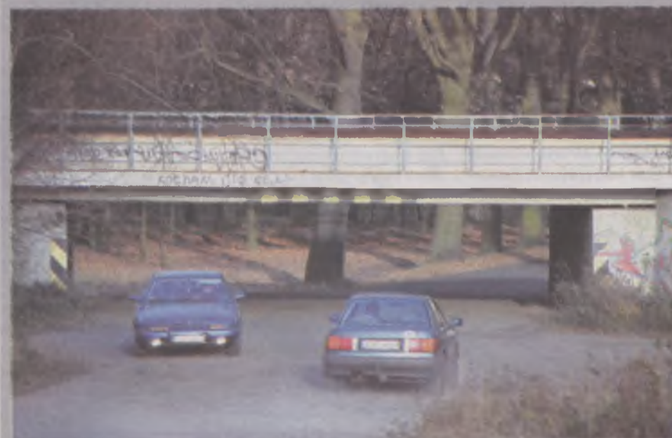
Dzisiaj pod tym wiaduktem kolejowym w parku mogą przejechać tylko niskie auta. Gdy powstanie objazd, będą tędy jeździć autobusy
