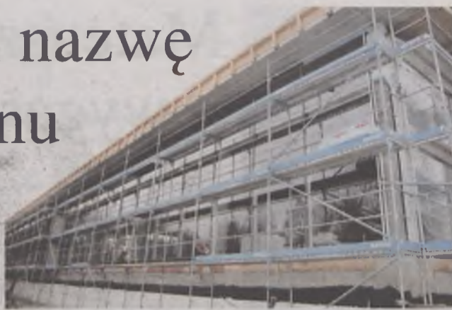
Basen w budowie czeka na swoją nazwę
