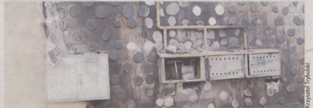
To palący się gaz, wydostający się ze skrzynek z licznikami, spowodował taki gwałtowny rozwój pożaru
