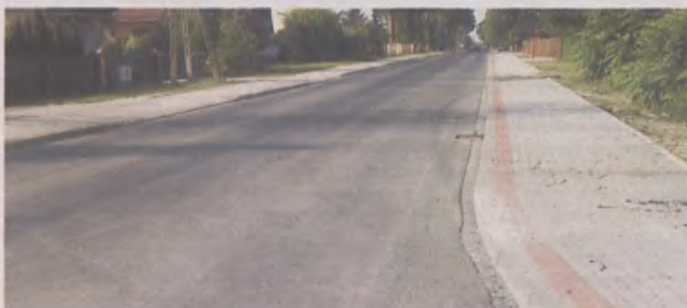
Kończy się modernizacja dróg powiatowych w gminie Jelcz-Laskowice, realizowana w ramach „schetynówek”, czyli Narodowego Programu Przebudowy Dróg Lokalnych 2008-2011
