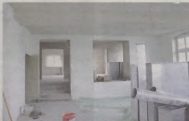
Obecny stan zaawansowania prac w bibliotece
