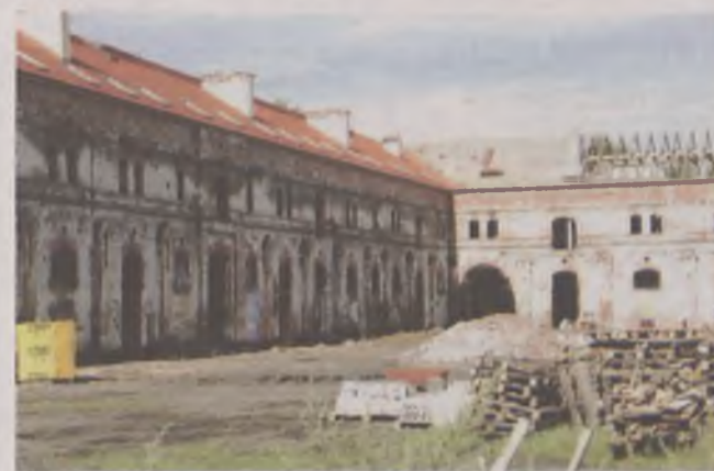
Na parterze tego pokoszarowego budynku będą biura Miejskiego Ośrodka Pomocy Społecznej
