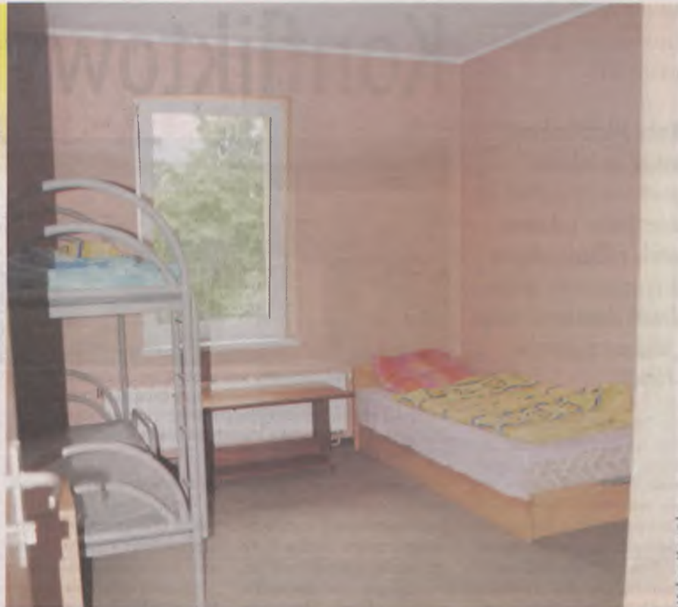
W ramach projektu wyremontowano wnętrze budynku - pokoje i łazienki
