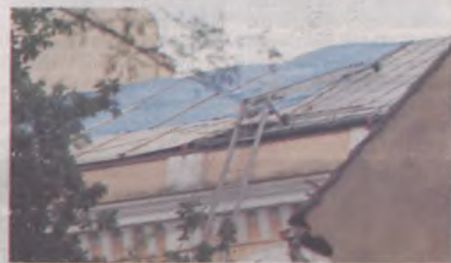
Remont dachu kościoła rozpoczął się 6 lipca
