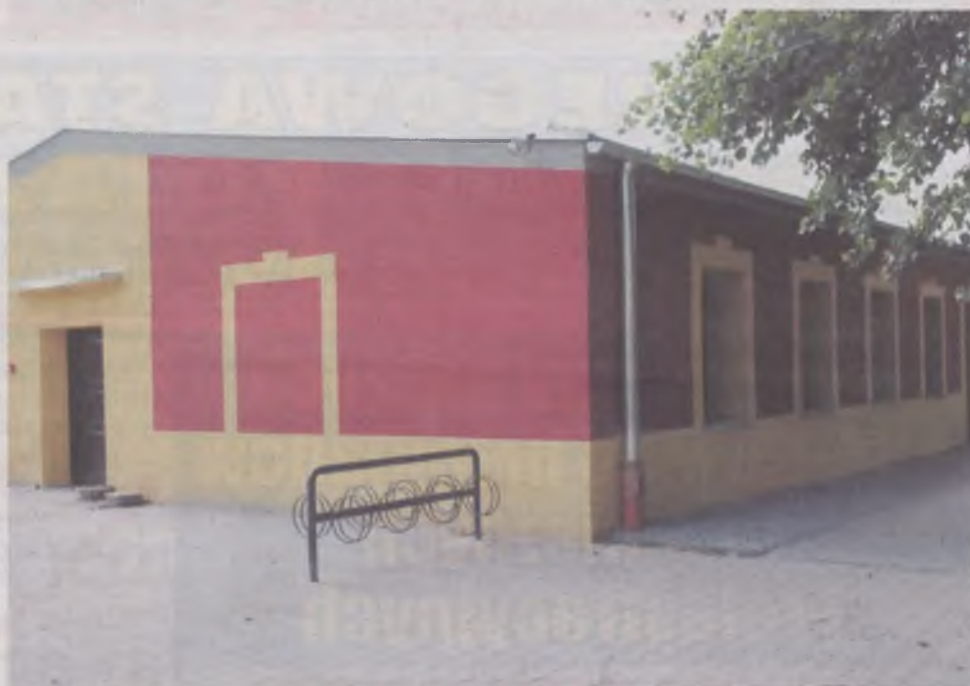
Swietlica „Opty” po termomodernizacji
