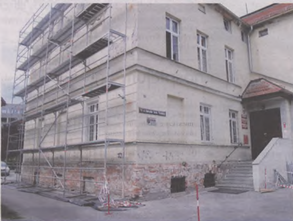
Prace przy budynku oławskiego Urzędu Gminy prowadzone są pod nadzorem konserwatorskim
