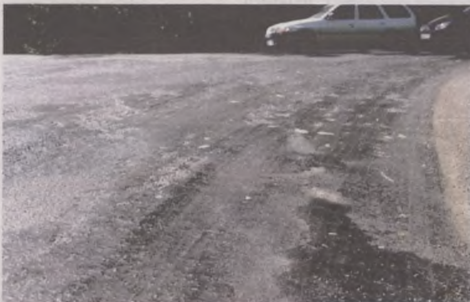
To zdjęcie z 25 maja - rozgrzana nawierzchnia błyszczy w słońcu i klei się do opon
