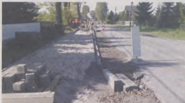
Modernizowana droga nr 1535D - na fot. remontowana ulica Oleśnicka w Jelczu-Laskowicach
