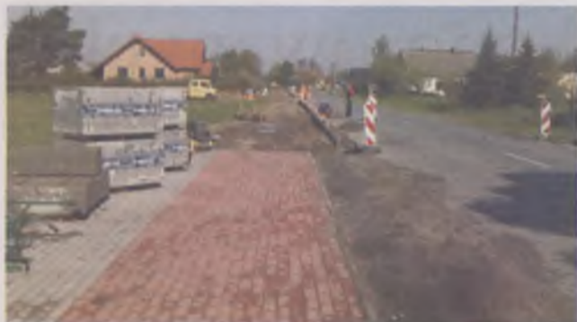
Trwa przebudowa drogi powiatowej nr 1538D w gminie Jelcz-Laskowice - na zdjęciu modernizowany odcinek w Miłoszycach
