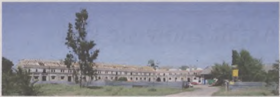
Budowa mieszkań TBS przy ul. 3 Maja
