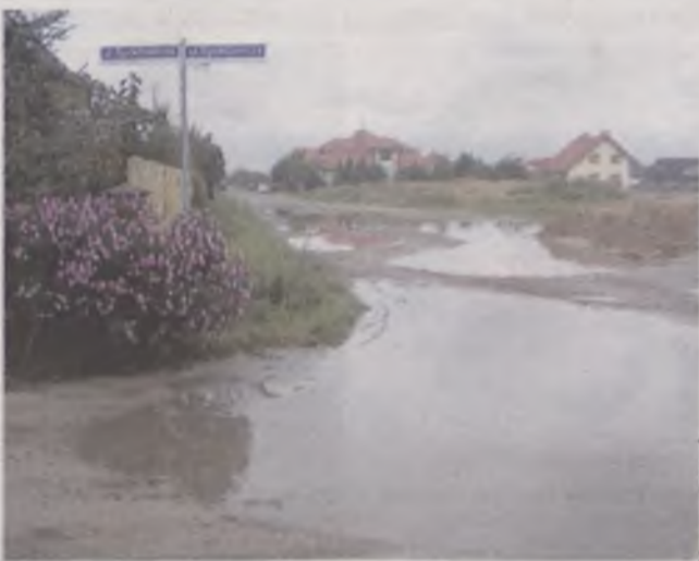
Ulice Spółdzielcza i Letnia w Marcinkowicach bardziej nadają się na wodne safari niż na drogi dojazdowe do domu
