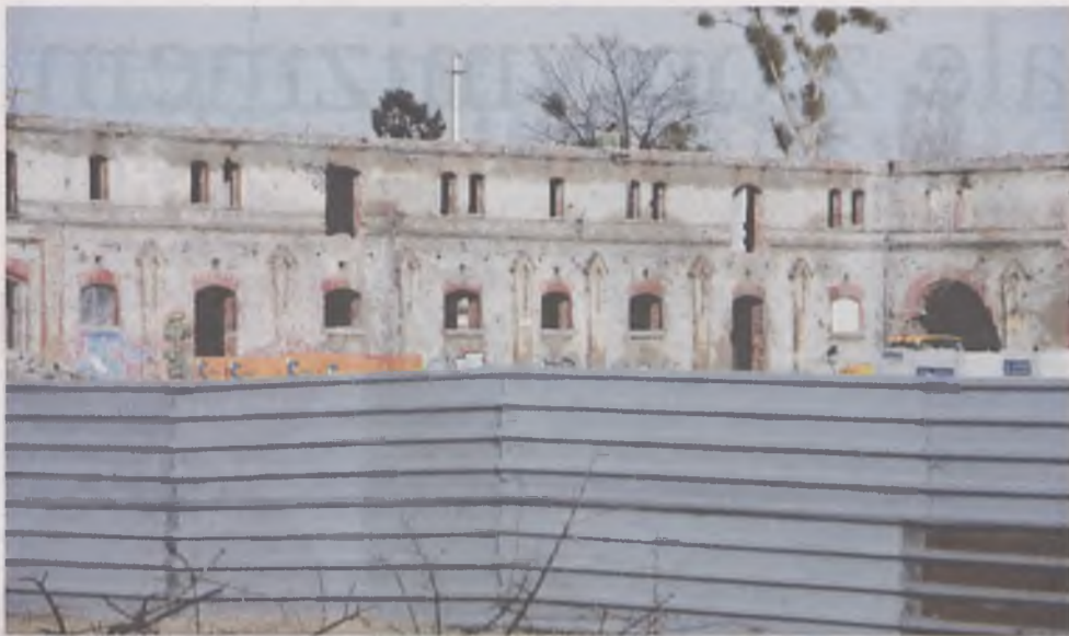
Lewa strona - tu trwają prace
