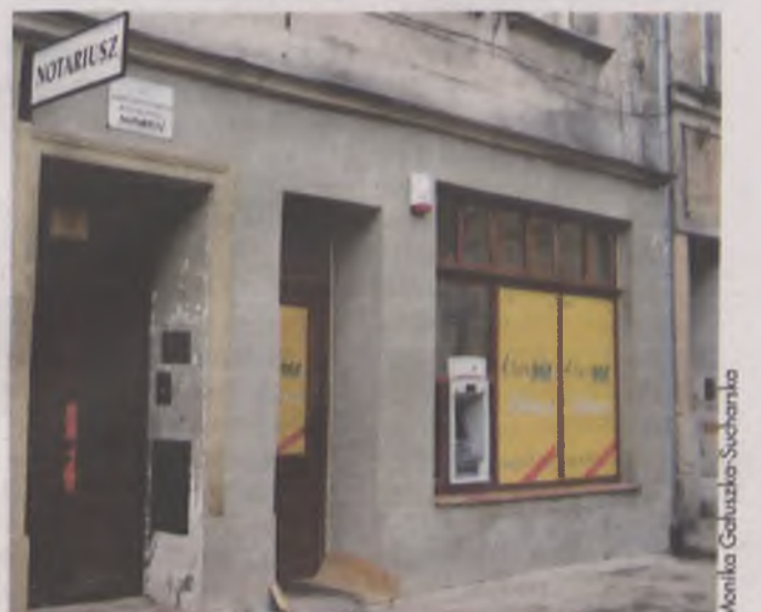
Nowy bank będzie się mieścił na Wrocławskiej - jeszcze trwają tu prace remontowe
