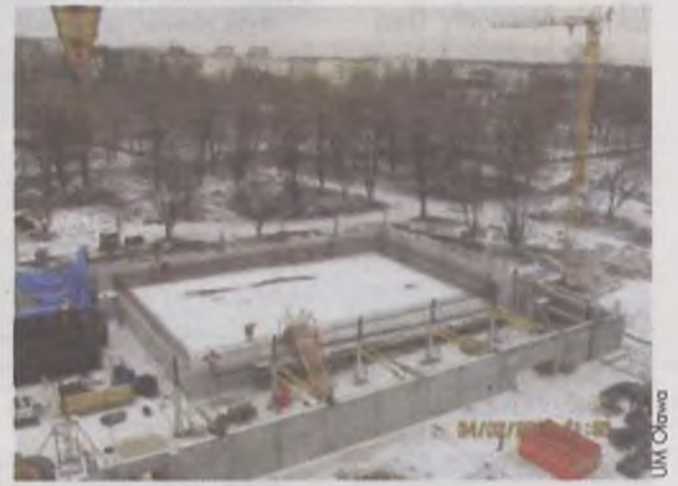
Tak wygląda plac budowy basenu
