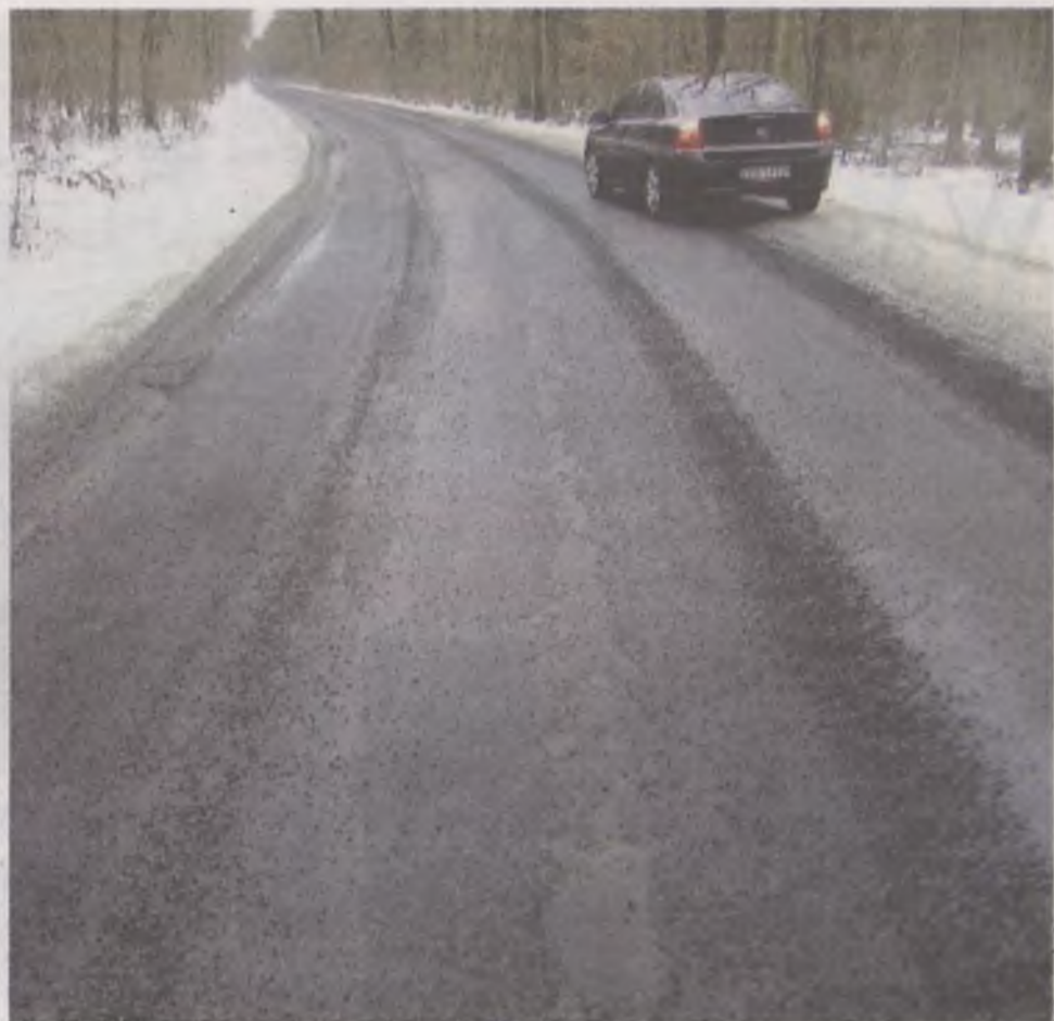
Na remontowanej jesienią drodze z Janikowa do Jelcza-Laskowic przez Hannę zalega warstwa grysu, a w nowo położonej nawierzchni są ubytki
